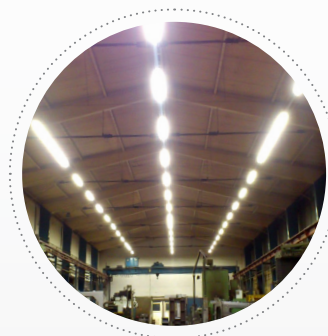
Po inštalácii nového osvetlenia
